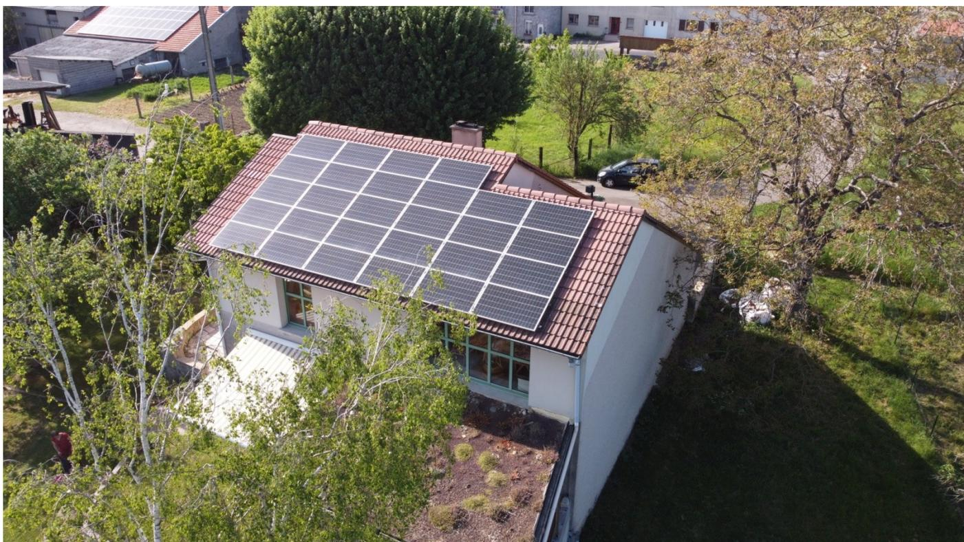
*Toiture au premier plan de 9 KWc (28 panneaux) et au second plan de 36 KWc (108 panneaux ) à Ognéville.*
